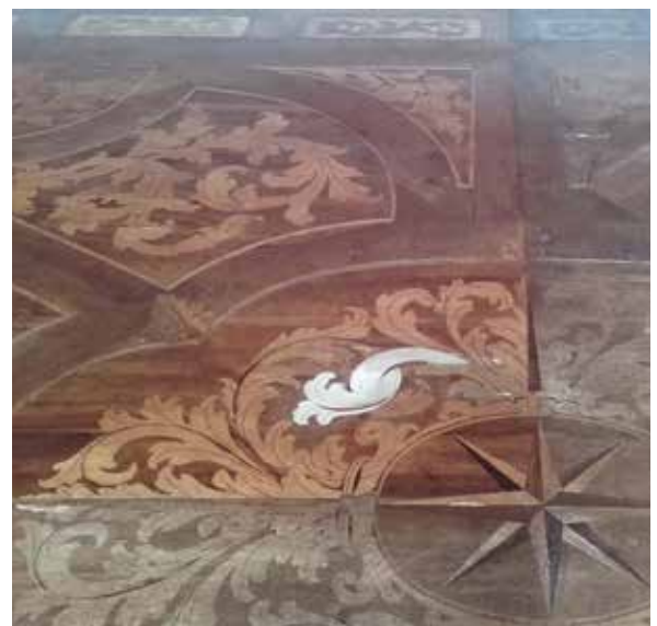
Audienzzimmer: Rekonstruktion einer Blattintarsie mit Brandschattierung. Quelle: RSP GmbH
