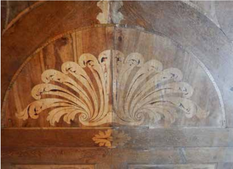
Audienzzimmer: Musterfläche, Abnahme des degenerierten Wachsüberzugs; Quelle: RSP GmbH
