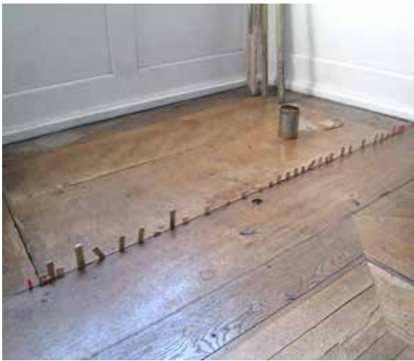
Privatkapelle: Einseitiges Verleimen eines lose liegenden Holzspans. Quelle: RSP GmbH
