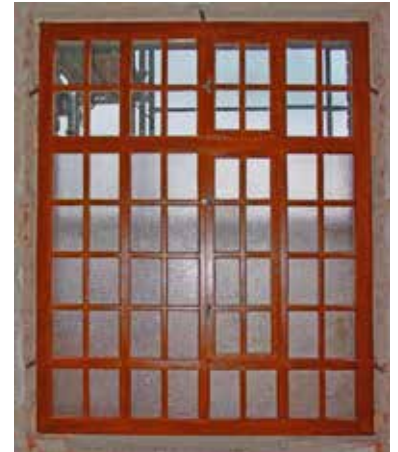
Endzustand nach Einbau mit teilweise genölpeltem Glas, Ansicht innen
