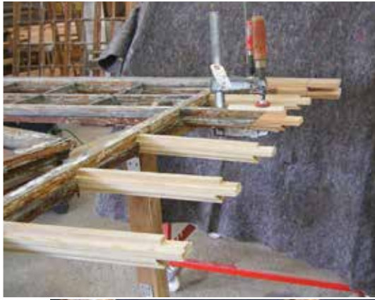
Konstruktive Holzergänzungen
