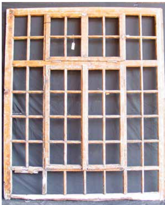
Zwischenzustand nach dem Ausglasen und der Abnahme der Farbschichten
