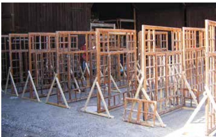
Grundierung mit rohem Leinöl
