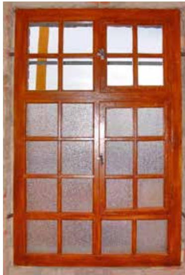
Endzustand nach Einbau mit teilweise genölpeltem Glas, Ansicht innen
