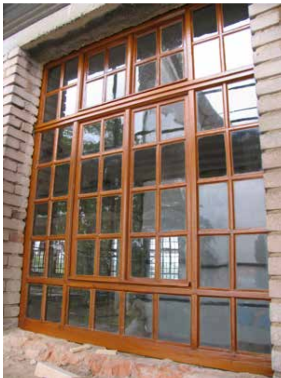
Endzustand nach Einbau, Ansicht außen
