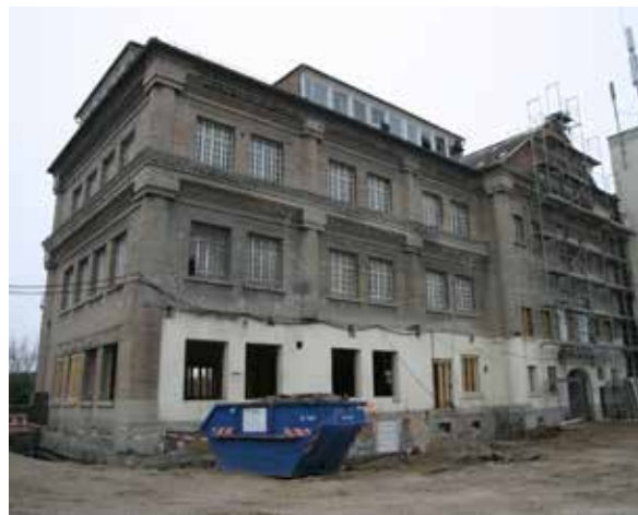
Ehemalige Schuhfabrik Manz Fortuna bei Beginn der Restaurierung 2006
